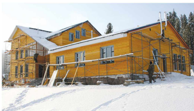
2011 год. Строительство Визит-центра природного парка «Ергаки»
