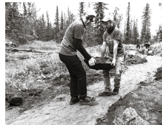
Волонтеры обустривают экотропу
