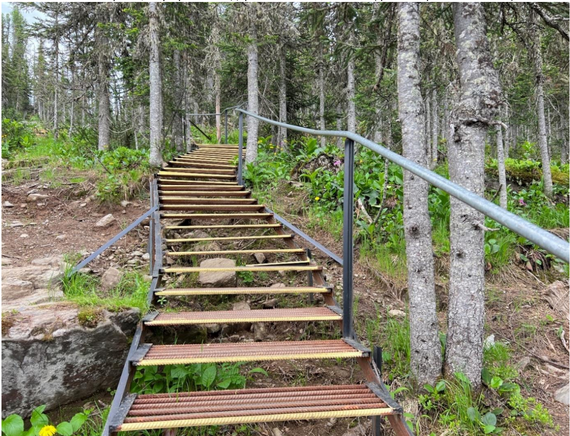
Участок тропы, обустроенный лестницей из железных прутьев (фото Берляковой Анны)
