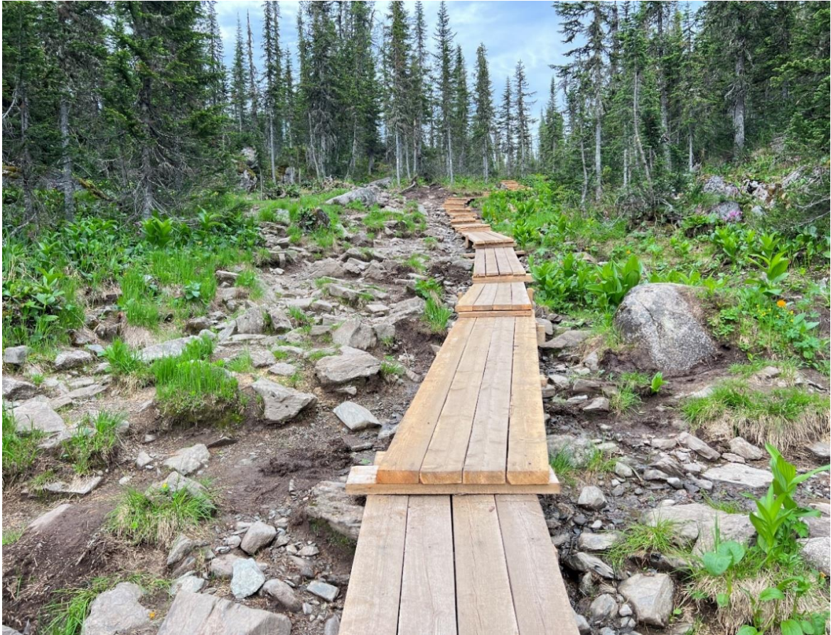
Участок тропы, обустроенный деревянными настилами (фото Берляковой Анны)
