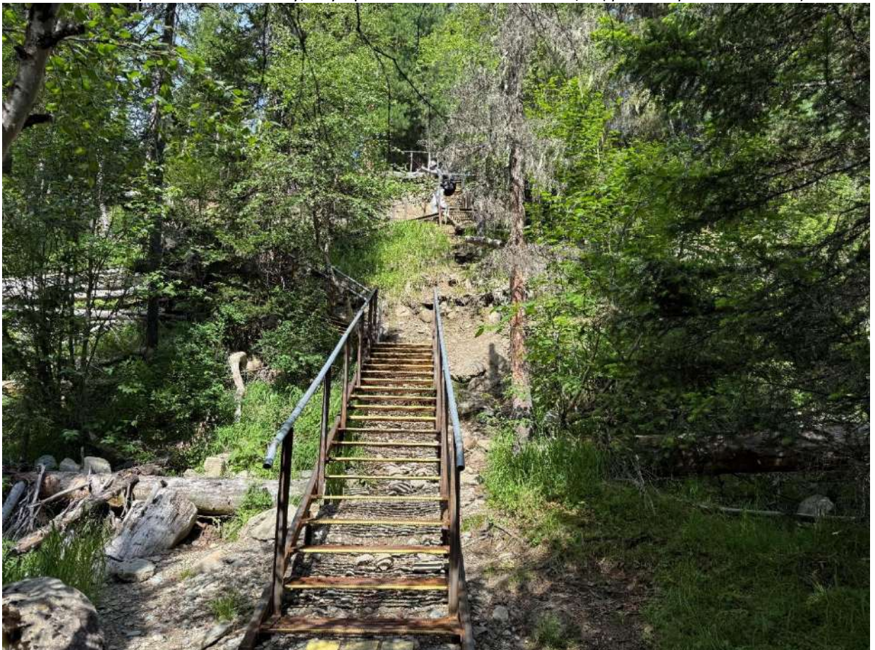
Участок тропы в районе «Муравьиной горки» обустроенной железной лестницей (фото Берляковой Анны)
