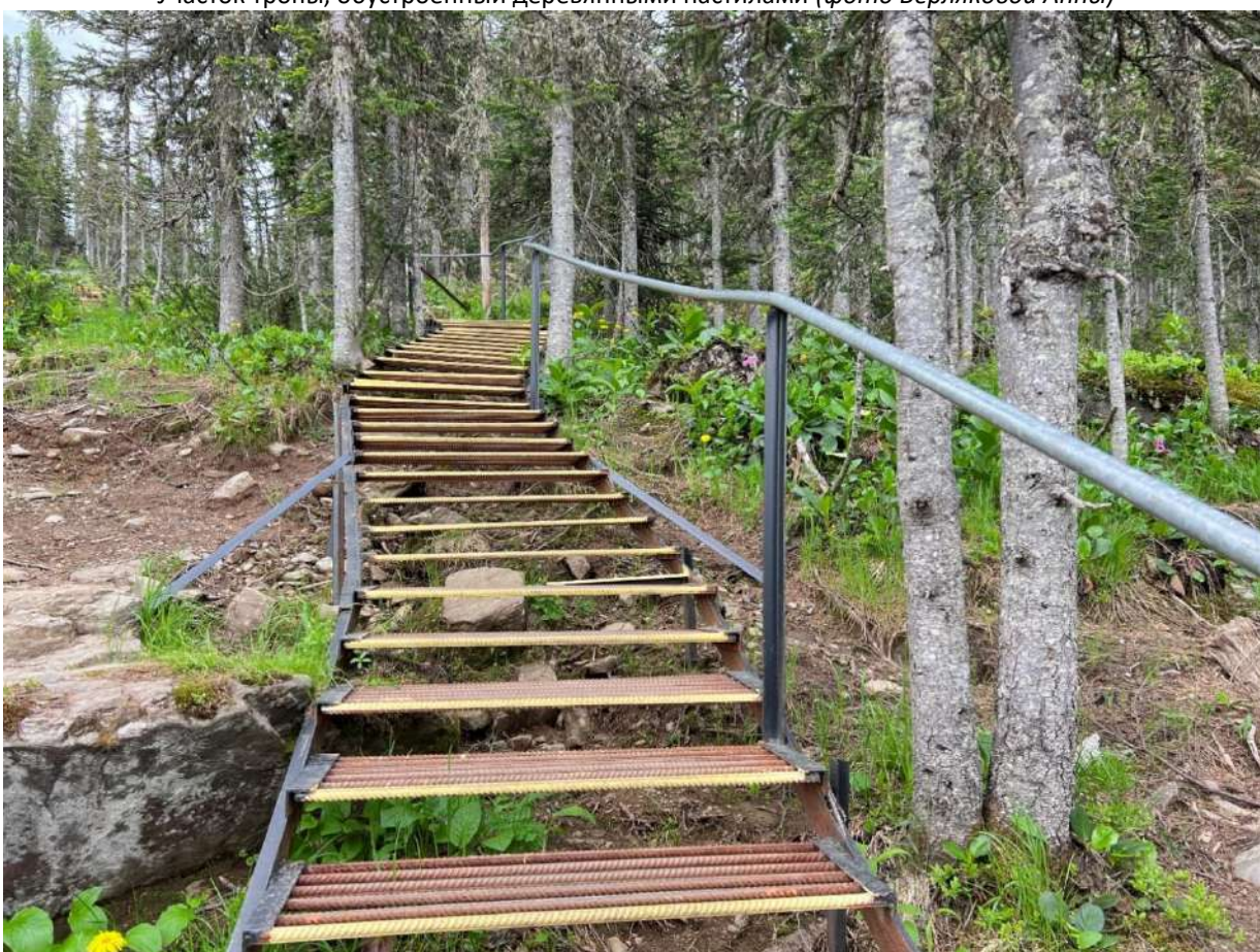
Участок тропы, обустроенный лестницей из железных прутьев (фото Берляковой Анны)
